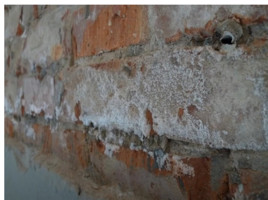
Ogledni primjerak iscvjetavanje soli u fazi isušivanja
